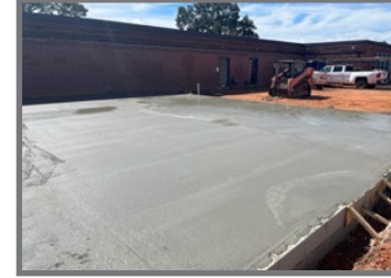
Slab Prep and Pour
