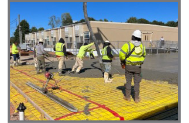
Slab Prep and Pour
